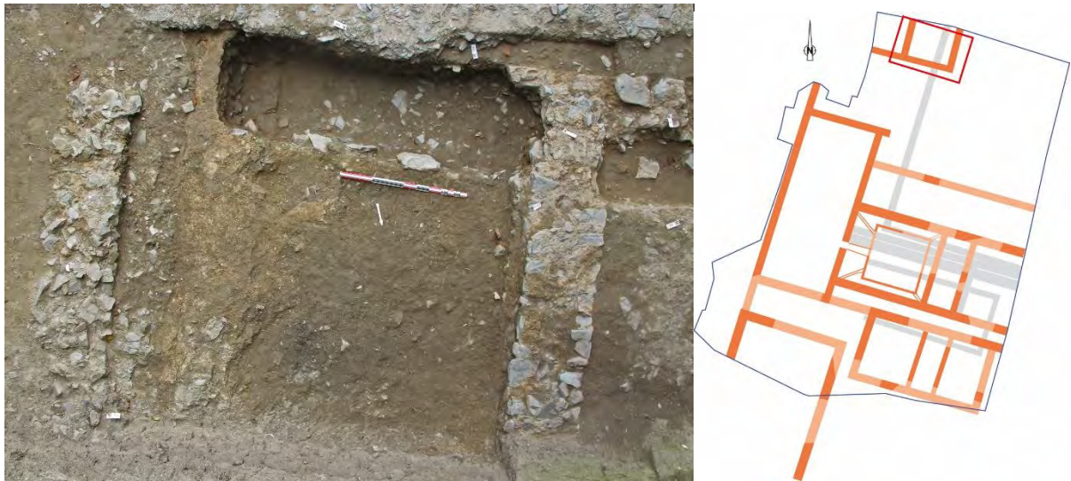
Fig.1-136 Vue verticale des murs MR1047 et 1049. Noter le soin apporté à la mise en œuvre de MR1049 qui est en adéquation avec la présence d'une élévation conséquente. Celle-ci contraste fortement avec le mode de construction de MR1047 aux fondations nettement plus légères © Dominique Pouille Inrap
