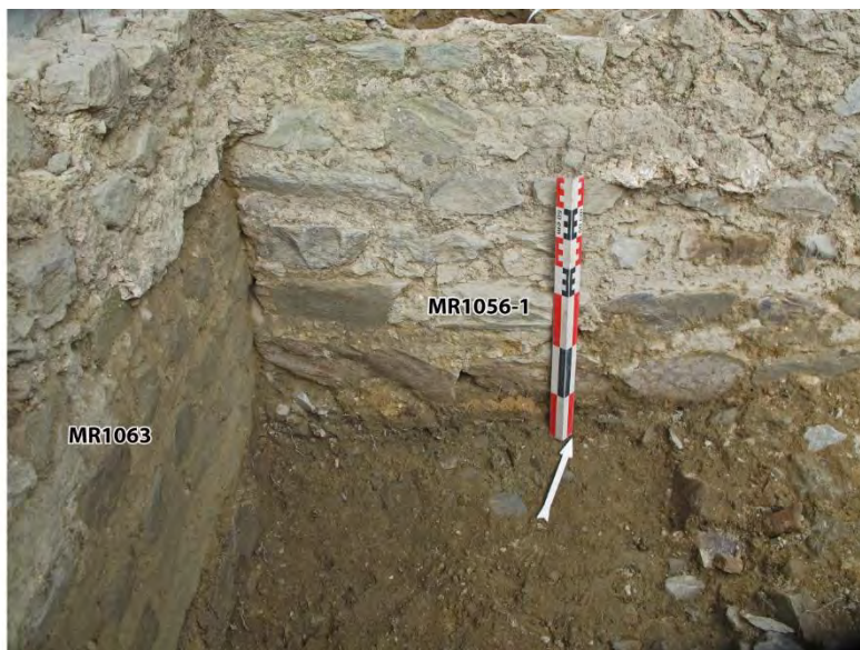
Fig.1-56 La partie inférieure 1056-1 du mur MR1056 s'appuie simplement contre le parement oriental du mur 1063. Aucun harpage n'existe, par ailleurs un étroit espace est présent au niveau de la jonction des deux murs © Dominique Pouille Inrap
