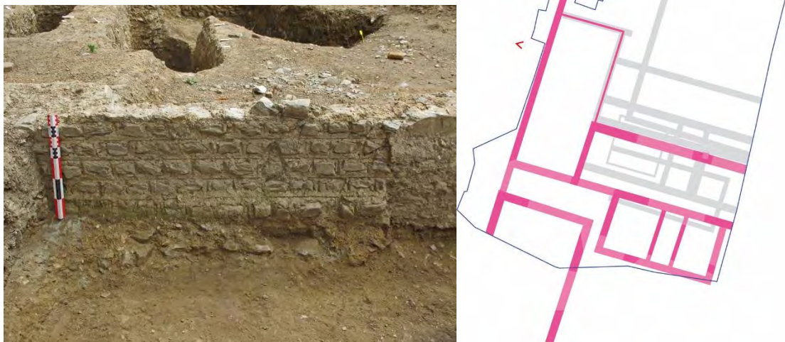
Fig.1-53 Parement de la face occidentale du mur MR1063 présentant un petit appareil régulier avec joints tirés au fer. Noter que dès l'origine il s'agit d'un mur de terrasse, puisque sur sa face nord le sol de circulation était situé nettement plus haut et devait avoisiner le sommet du mur © Dominique Pouille Inrap
