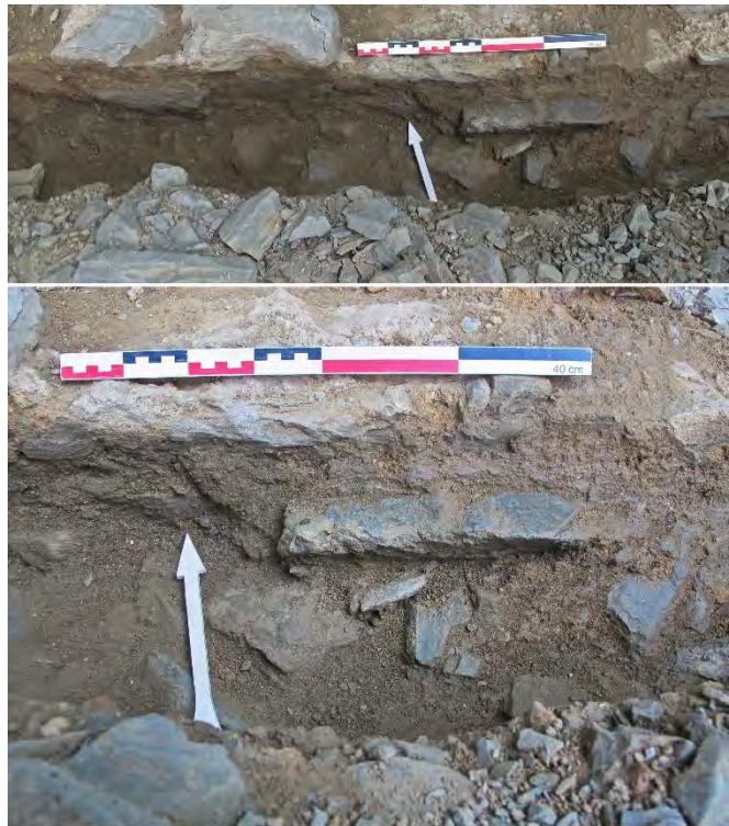
Fig.1-138 Vue de la tranchée d'installation présente sur le côté sud du mur MR1163. Celle-ci a permis la mise en place des premières assises de fondations maçonnées de la construction. Les joints sommairement lissés témoignent du mode de mise en œuvre mais également du fait que cette partie de la maçonnerie était destinée à être masquée © Dominique Pouille Inrap
