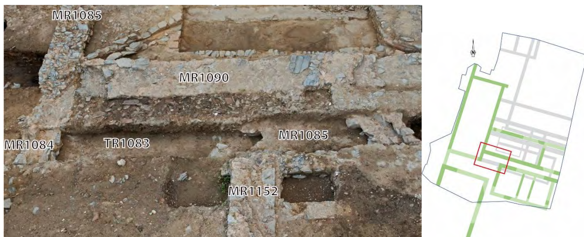
Fig.1-97 Vue d'ensemble des maçonneries correspondant à l'état 4 de la domus . Seul le tronçon TR1083 témoigne d'un épierrement jusqu'au sommet du radier de fondation du mur. Les autres maçonneries étant encore en élévation à cet état © Emmanuelle Collado Inrap
