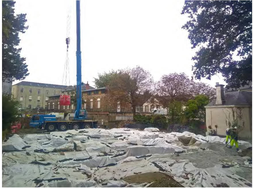
Fig.1-19 : Mise en place de la couche de stabilisé protégeant les vestiges © Dominique Pouille Inrap
