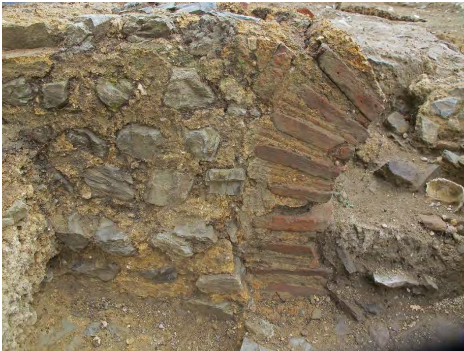
Fig.1-123 Détail du jambage nord de la bouche du prae-furnium et du départ de la voûte, maçonnés tous deux en fragments de briques et de tuiles à rebord. Noter les joints tirés au fer à l'aide d'un fer large. Ceux-ci s'apparentent à ceux observés au niveau des murs MR1160 et MR1082 © Dominique Pouille Inrap
