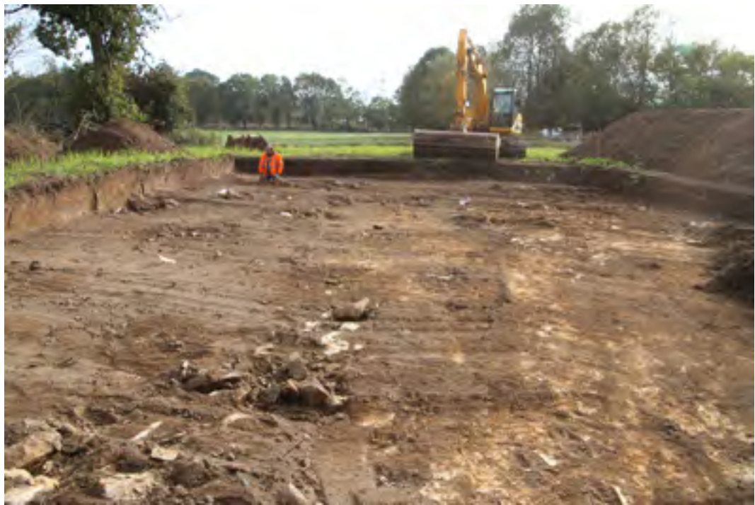
Fig. 19 Vue d'ensemble de la tranchée 3 © S. Sicard, Inrap
