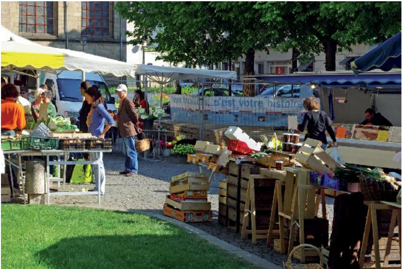
Fig. 8 Vue du chantier, le jour du marché. © Laurent Beuchet, Inrap
