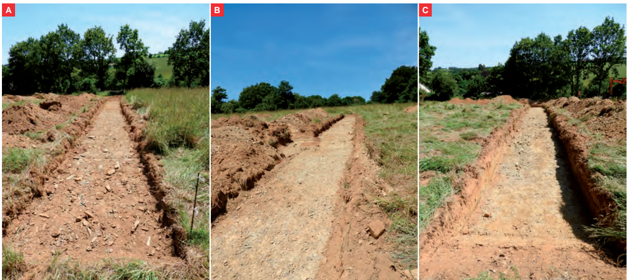
Fig. 4 Vues des tranchées 1(A), 2(B) et 3(C).
