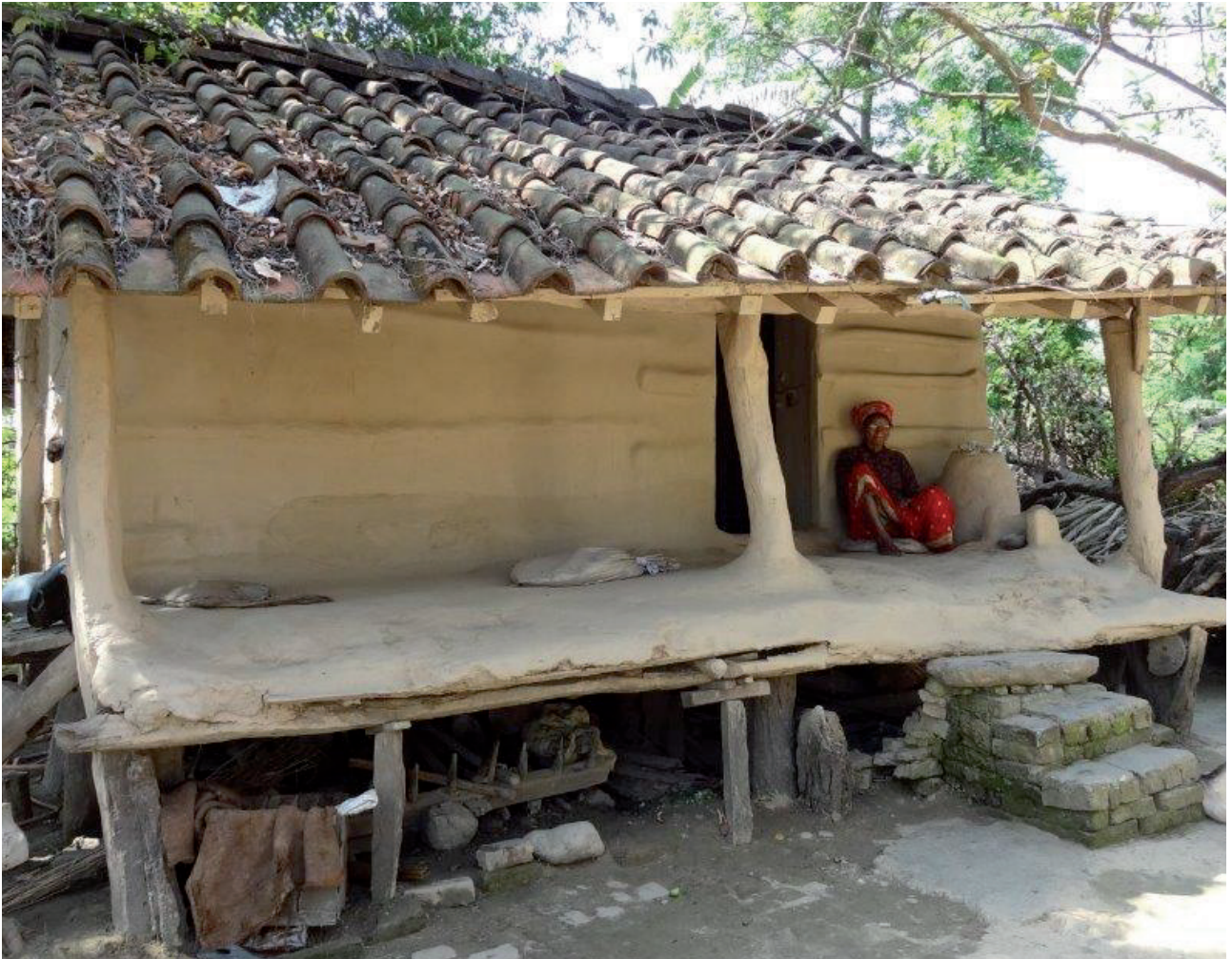
Fig. 14 Maison népalaise traditionnelle sur plancher surélevé à Mahendranagar. Les poteaux sont enduits d'argile afin de les protéger (© Edith Ogrodzinski)
